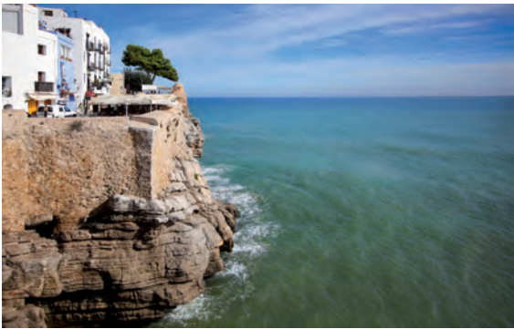
Muralla, vista este
